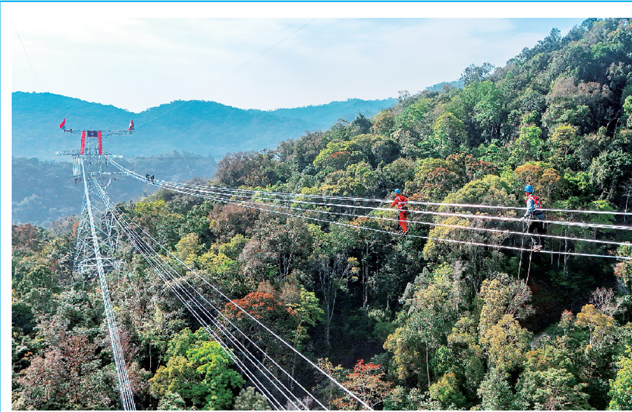
2 月 5 日,施工人员分别从位于中国和老挝境内的铁塔相向出发,前往线路连接点汇合(无人机照片)。 当日,中老 500 千伏联网工程中国段和老挝段输电导线在中国云南省磨憨与老挝磨丁交界处实现物理连通,标志着该工程国内外线路全线贯通。该项目是继中老铁路之后,中老两国共建“一带一路”的又一标志性工程。 新华社记者 彭奕凯 摄
